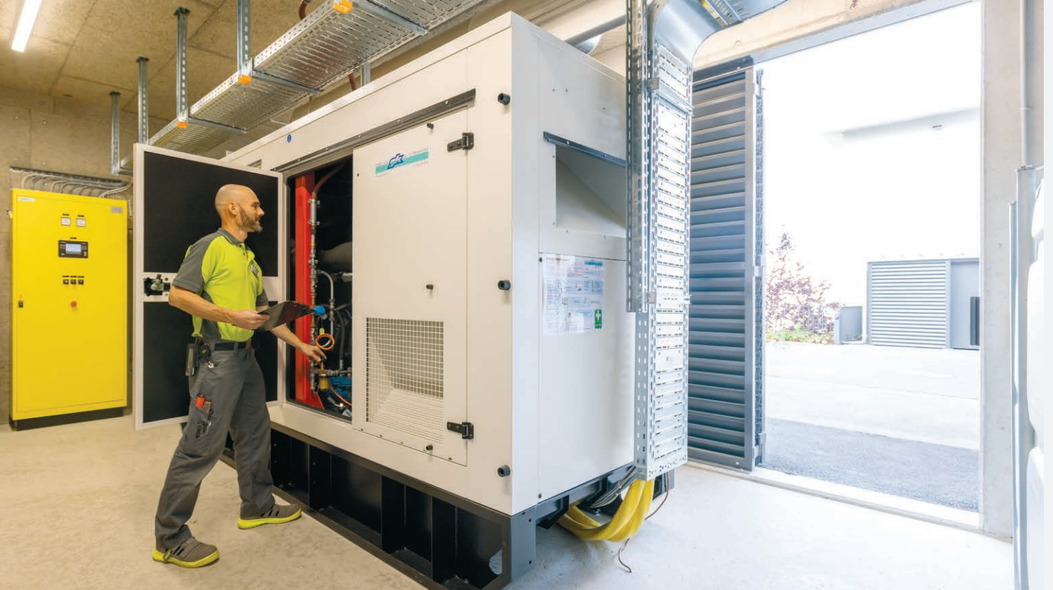
Res Hälén vom Technischen Dienst checkt das GERBE-Notstromaggregat, damit die Maschine im Ernstfall auch jederzeit anspricht.
