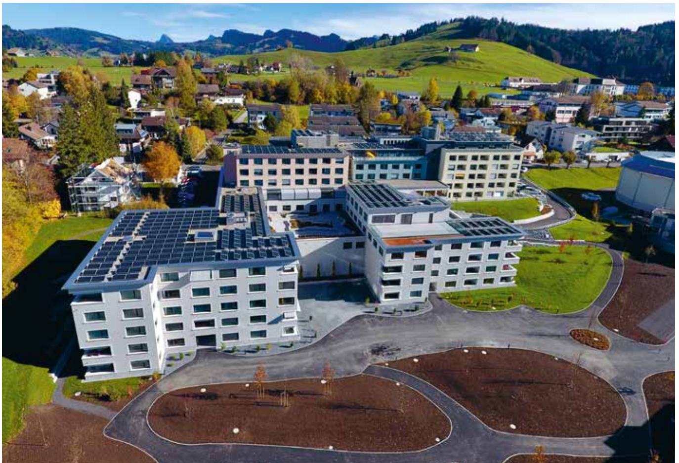
25. 10. 2017: Die Bauarbeiten sind weitgehendst abgeschlossen.
