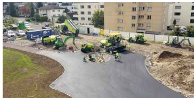
6. 9. 2017: Der GERBE-Park wird gebaut.
