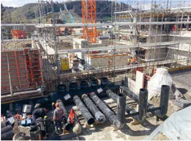
30. 3. 2016: Einbau Lüftungsrohre.
