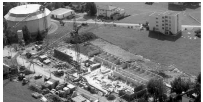
Der Bauplatz kurz nach Baubeginn am 29.4.1976.
