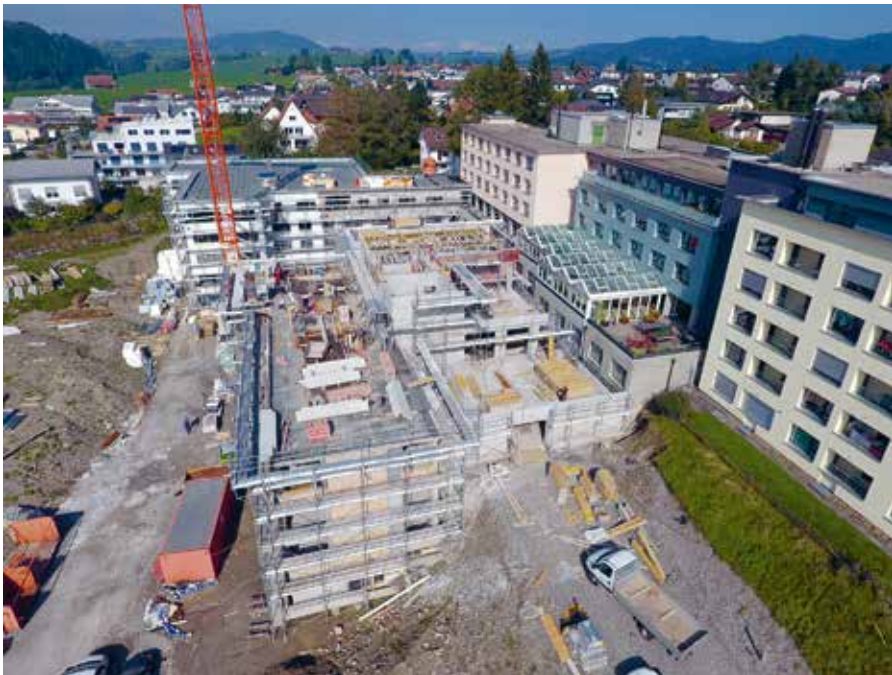
22. 9. 2016: Die Baustelle aus der Drohnenperspektive.
