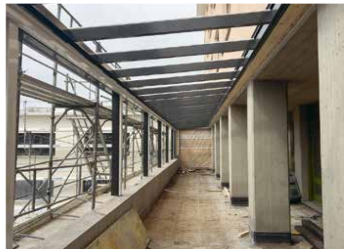
11. 5. 2017: Durchgang (noch ohne Verglasung) zu Haus 3.
