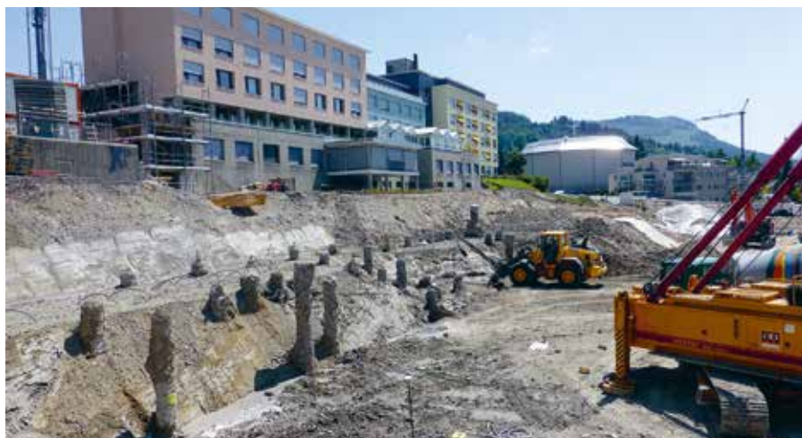
2. 7. 2015: Pfählungsarbeiten zur Sicherung des Bauuntergrunds.
