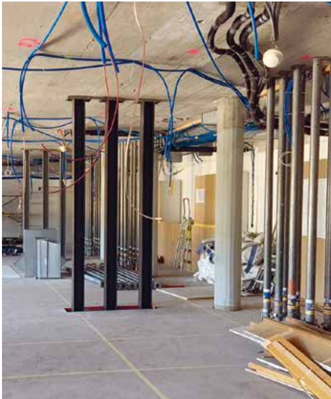
26. 5. 2017: Die Statik im Speisesaal wird verbessert.
