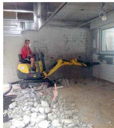
24. 8. 2015: Abbruch alte GERBE-Küche.
