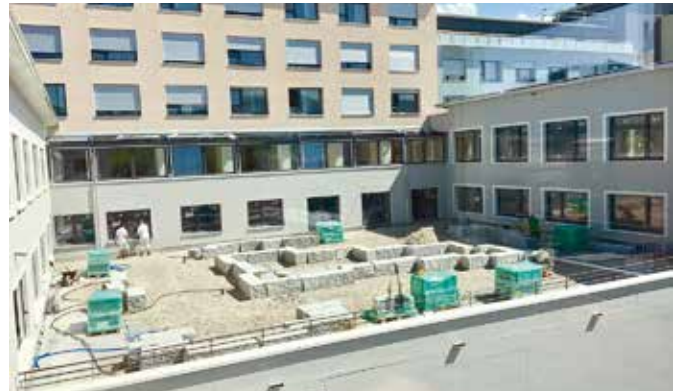
18. 8. 2017: Der Dachgarten entsteht.
